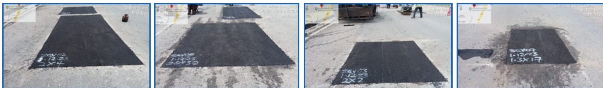
Exit Highway Ke Pesisir Pulau Jaya Utara 2
